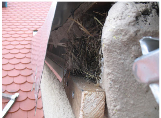
Erhaltene Nester bei Dachsanierung in Giesing
