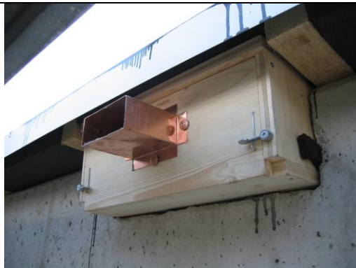
3 Eingesetzter Nistkasten mit Kriechtunnel durch die Wärmedämmung
