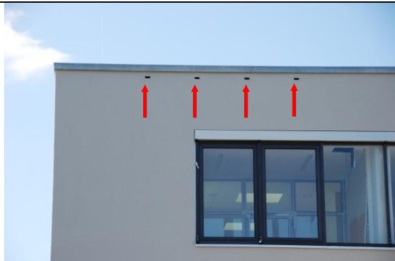
7 Vier Mauersegler-Brutnischen am Dachrand
