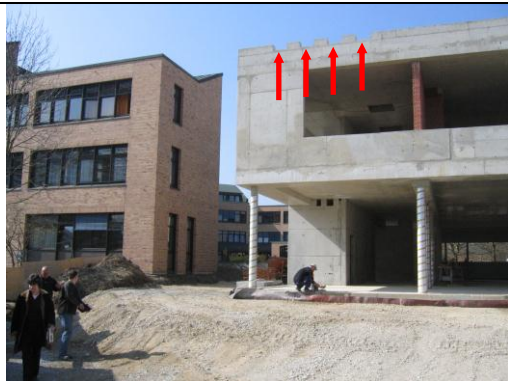
5 Aussparungen im Rohbau zur Aufnahme der Nistkästen
