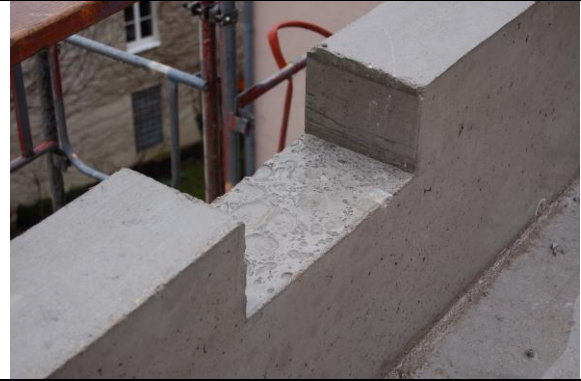
2 Aussparungen für Nistkästen im Rohbau
