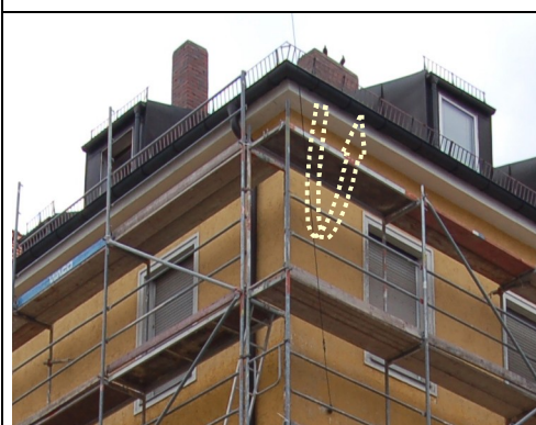
1 Ursprüngliches Gerüst: Anflug ist nicht möglich
