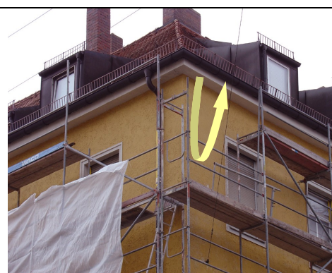
2 Nach dem Gerüstumbau: Anflug ist wieder möglich
