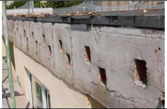
2 In den Durchlüftungsöffnungen lagen die ursprünglichen Quartiere
