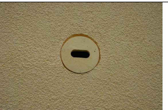
6 Niststein für Mauersegler, fertig verputzt
