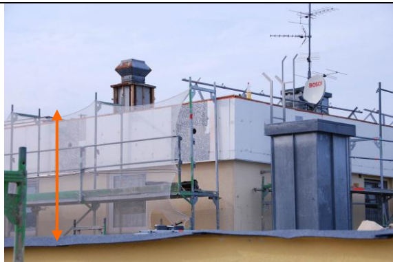
3 Vernetzung des oberen Gerüstbereiches zum Schutz der Mauersegler
