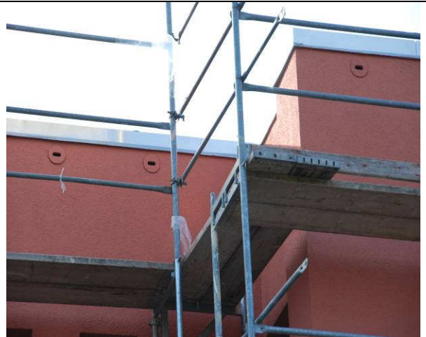
2 Fertig eingebaute und verputzte Mauerseglerniststeinen
