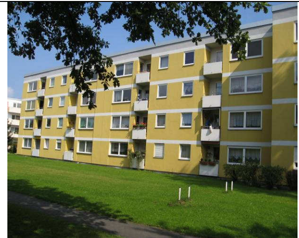
4 Zweiter der insgesamt drei betroffenen Bauabschnitte vor der Sanierung
