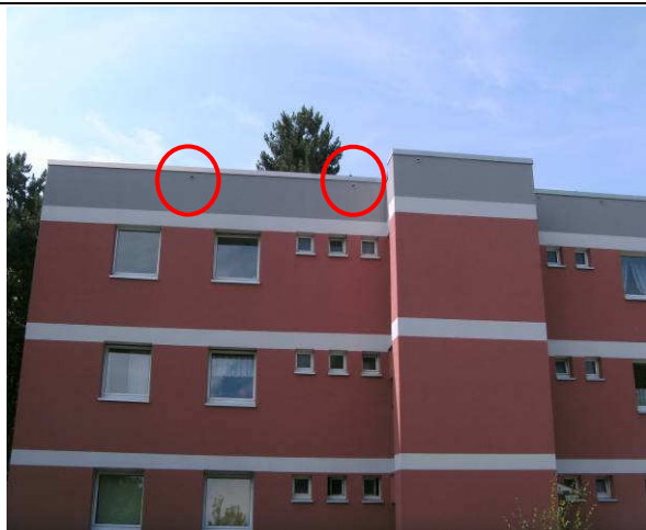
3 Das fertig gedämmte Gebäude mit Mauerseglerniststeinen im Attikabereich
