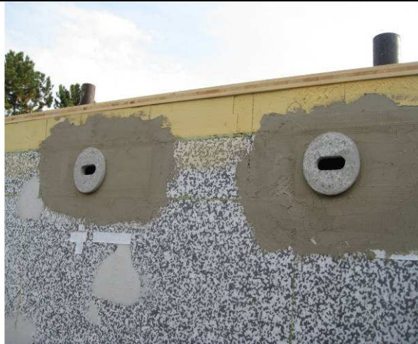
5 Mauerseglerniststeine im zweiten Bauabschnitt Noch nicht verputzt
