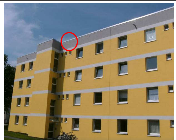
6 Zweites fertig gedämmtes Gebäude mit Mauerseglerniststeinen
