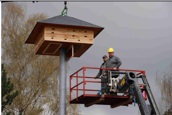
5 Feinjustierung und Befestigung des Nistaufsatzes
