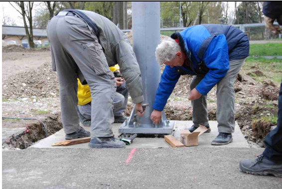
3 Befestigung des Mastes auf dem Fundament
