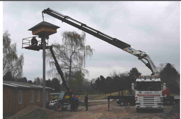
4 Aufsetzen des Nistaufsatzes mit einem Autokran
