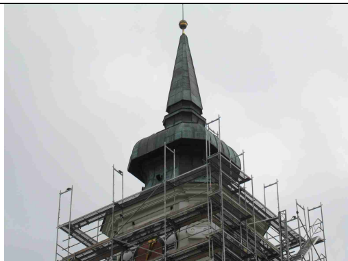
5 Stopp des Gerüstaufbaus am 31. März
