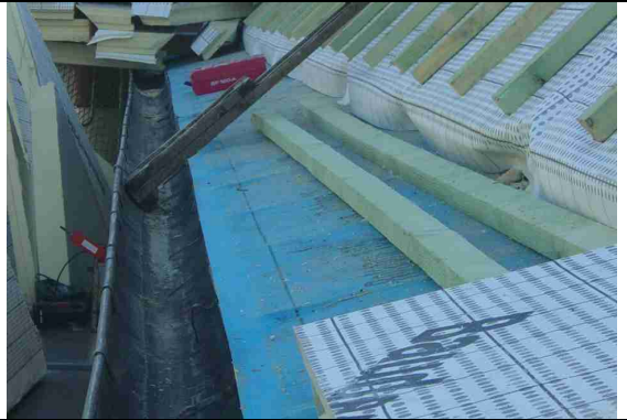
2 Die Dämmung musste bis an den äußeren Dachrand gezogen werden
