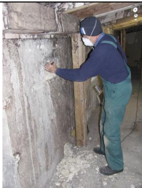
6 Entfernung von Kot am vorhandenen Nistplatz
