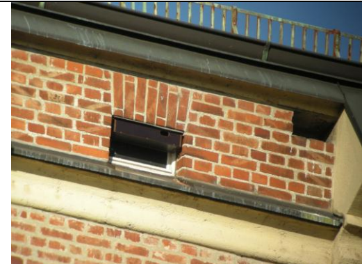
10 Ein Mauerseglerkasten in Nahaufnahme; von unten ist er nicht zu sehen.
