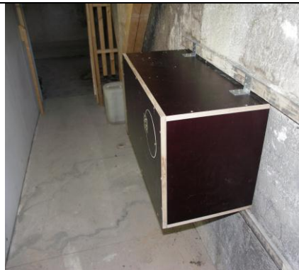
7 Der fertig montierte Kasten im „Turmalkengang“
