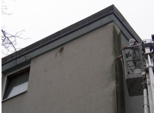
8 Bauabschnitt II und III: Die Spechtlöcher werden im Februar, vor Beginn der Brutzeit verschlossen
