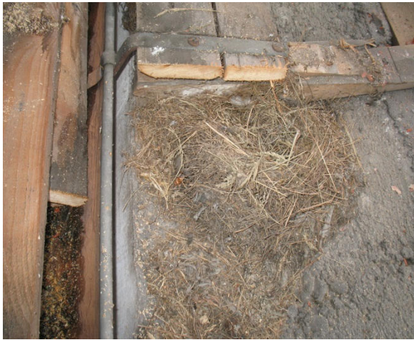
3 Ehemaliges Spatzennest - häufig werden diese von Mauerseglern genutzt. Dennoch gibt es in den letzten fünf Jahren vor der Sanierung keine Hinweise auf Haussperlingsvorkommen.
