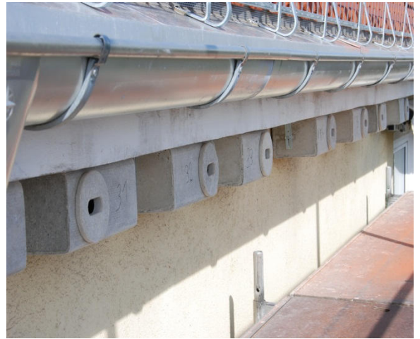
4 Reihe mit Ersatznistkästen für Mauersegler nach der Dachsanierung
