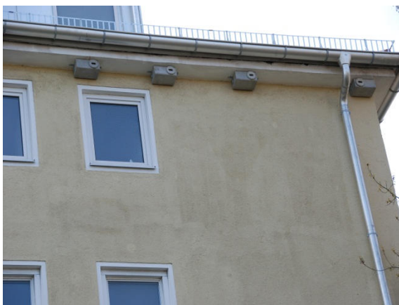
5 Die Mauerseglernistkästen neben der neuen Regenrinne und dem neuen Regenfallrohr
