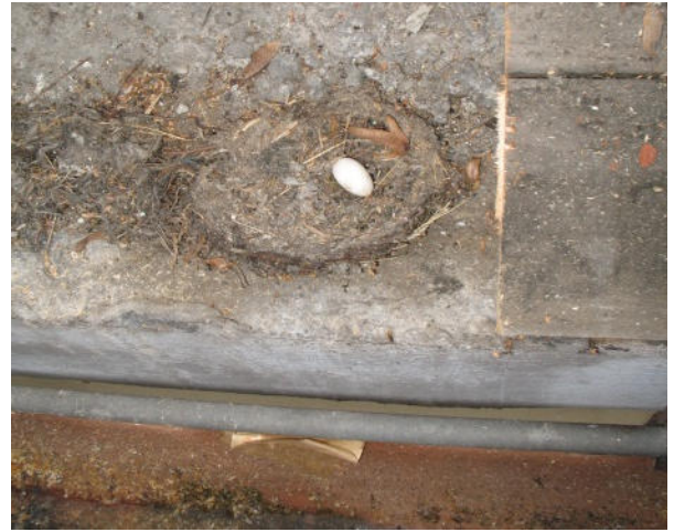
2 Mauerseglernest mit Ei bei der Dachöffnung
