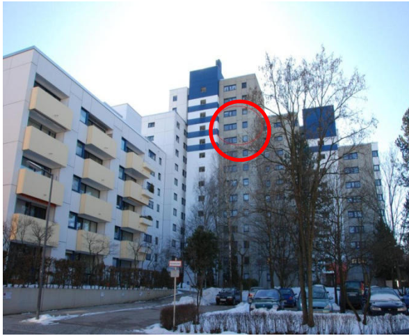
1 Die Wohnanlage mit den ursprünglichen Mauerseglerquartieren im markierten Bereich
