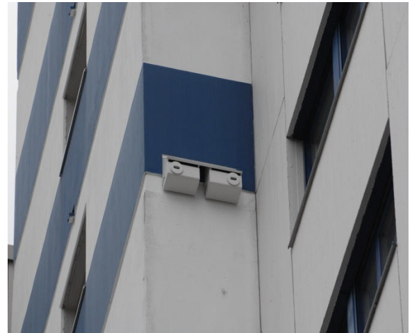
4 Mauersegler-nistkastenpaar. Das Überdach schützt vor Erhitzung und dient als Taubenabwehr
