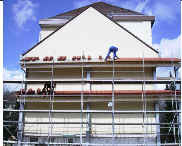
4 Bau der Schwalbenwand
