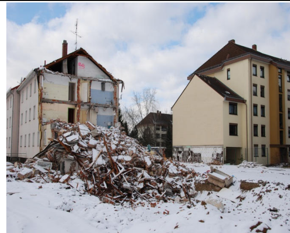
3 Teilabbruch der Mehrfamilienhäuser; rechts Standort der zukünftigen Schwalbenwand
