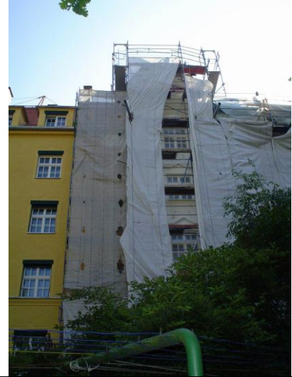
2 Erst nach Abschluss der Arbeiten auf der Nordseite wurde der Brutbereich komplett eingerüstet und mit einem Staubnetz versehen
