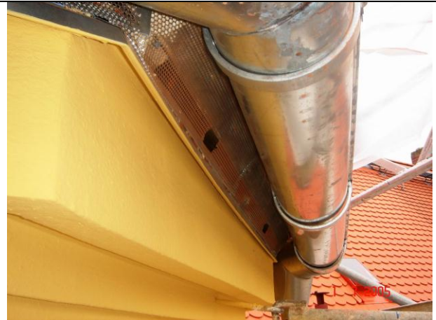
4 Öffnungen im Lüftungsgitter
