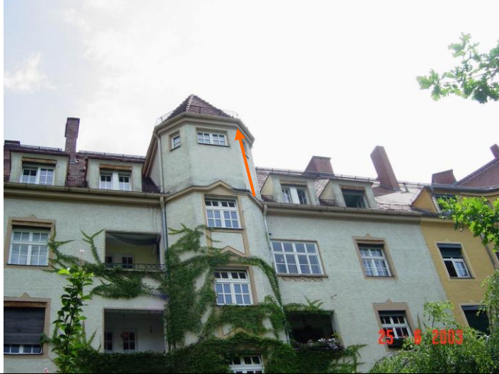
1 Mauerseglernistplatz im Bereich des Turmes
