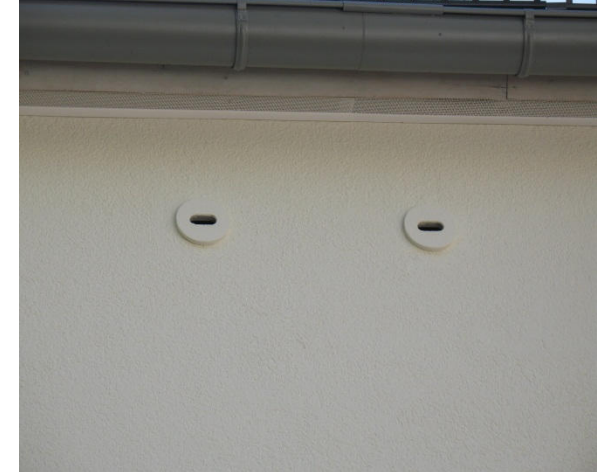
6 Neue integrierte Niststeine für Haussperlinge in der Fassade des Neubaus
