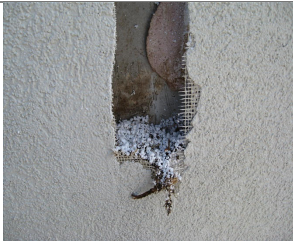
3 Detail: Öffnung eines der Nistplätze im Wärme-Dämmverbundsystem der benachbarten Giebelwand
