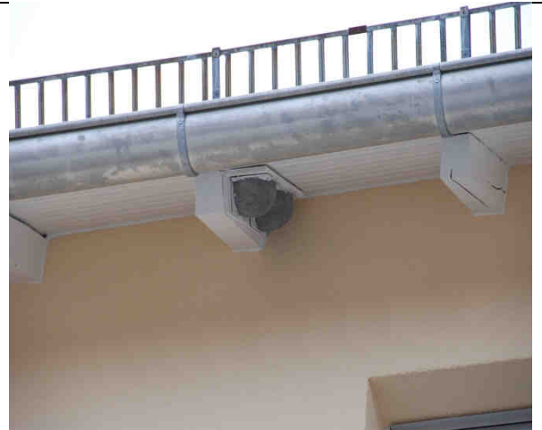
2 Fertige Ersatzquartiere für die Mehlschwalben nach der Fassadendämmung
