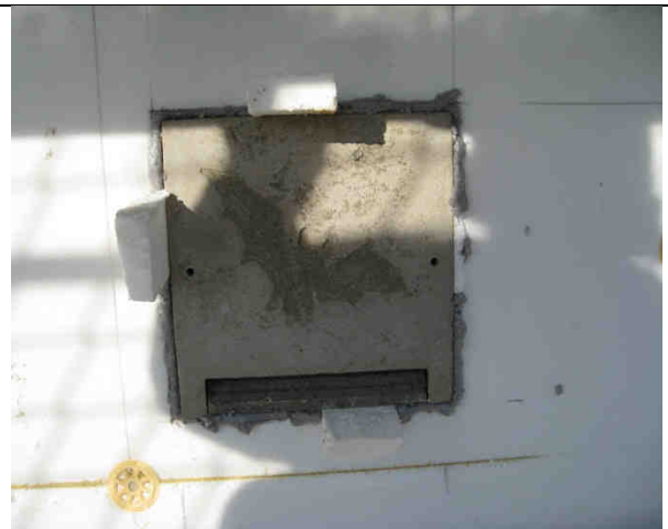
4 Einbau des Fledermausflachkastens für die Großen Abendsegler
