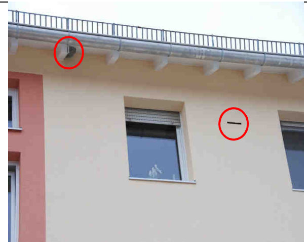
6 Lage der Schwalbennester und des Fledermausflachkastens am fertig gedämmten Mehrfamilienhaus
