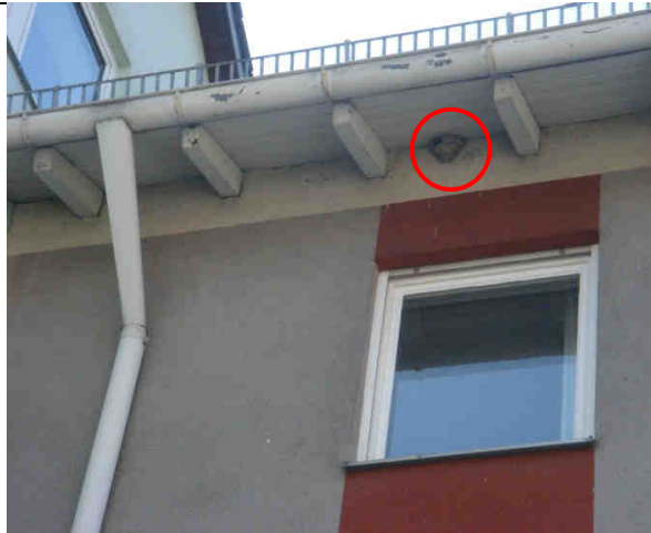
1 Mehlschwalbennest vor den Dämmmaßnahmen
