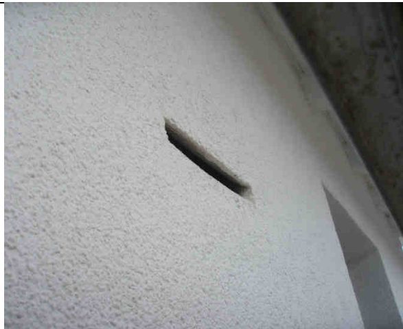
5 Einflugschlitz des Fledermausersatzquartiers nach abgeschlossener Fassadendämmung
