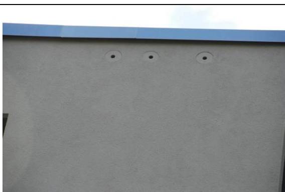
6 Fertig eingebauter Haussperlingsniststein
