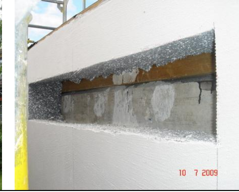
2 Ausparung in der Wärmedämmung für Niststeine
