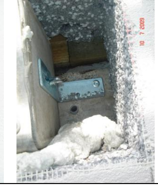
3 Befestigung des Niststeins im Mauerwerk
