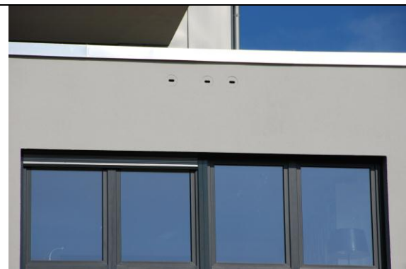
8 Fertig gestellte Fassade mit Mauersegler-Dreierquartier
