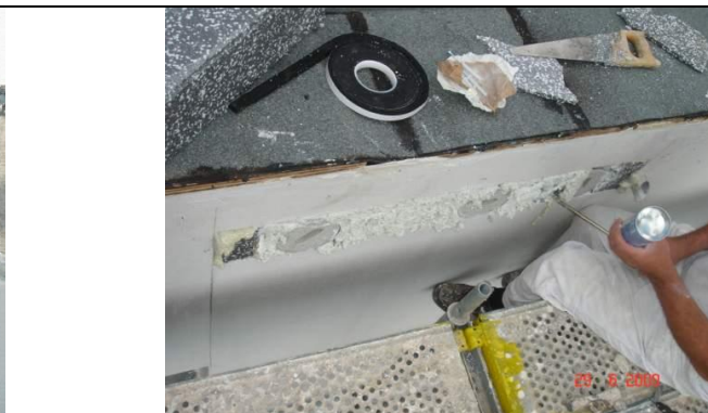
5 Anarbeiten mit Bauschaum an die Edelstahlmanschetten.
