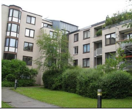
1 Wohnanlage vor der Fassaden-Dämmung
