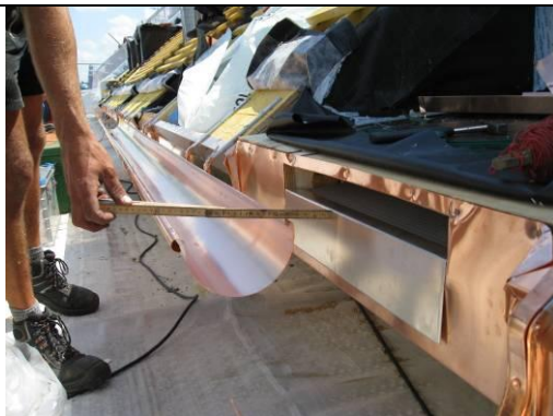
5 Der Abstand zwischen Dachrinne und Nistplatz ist breit genug, dass die Vögel einfliegen können
