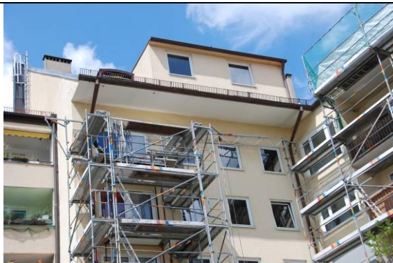
3 Im am stärksten bebrüteten Bereich wurde der Gerüstaufbau bis Brutende zurückgestellt
