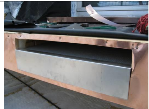
4 Neuer Nistplatz. Das vorgehängte Edelstahlblech ist noch nicht besandet (Einflughilfe)
