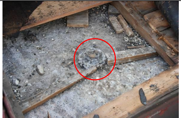
2 Ursprünglicher Brutplatz mit Mauerseglernest
