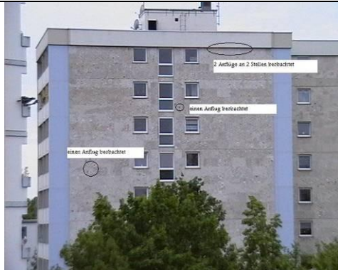
1 Einige der ursprünglichen Brutplätze in der Fassade und am Dachrand
