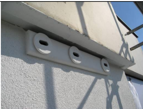
6 ...fertig eingebaut und in Fassadenfarbe gestrichen
