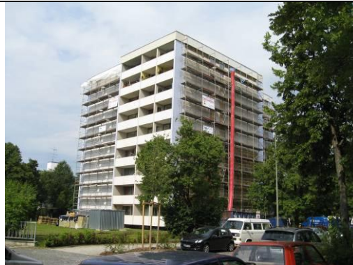
2 Das eingerüstete Haus – keine Anflugmöglichkeit für Mauersegler
