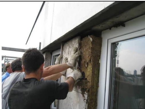
3 Sorgfältig werden die Natursteinplatten abgestemmt, um die Jungvögel zu befreien
