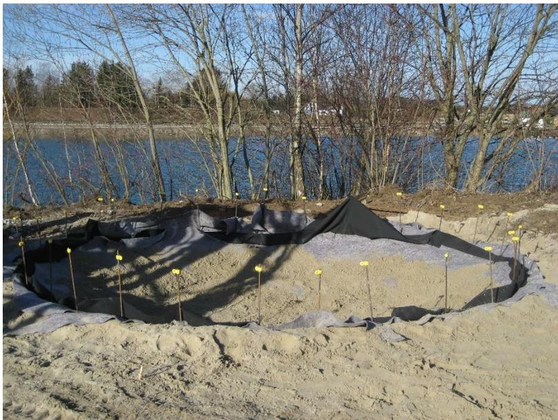
Bei einer Sandwich-Bauweise wird das auf der Folie liegende Schutzvlies nicht geschnitten, sondern am Rand untergeschlagen – so besteht weniger die Gefahr, die Folie zu zerstören.
