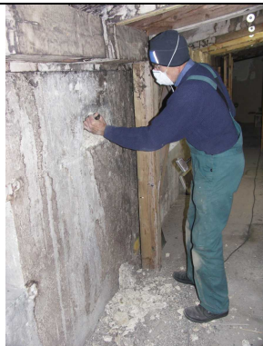
6 Entfernung von Kot am vorhandenen Nistplatz
