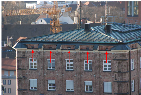
9 Südost-Seite des Hochhauses; hier wurden zusätzlich 5 Mauersegler-Nistkästen eingerichtet
