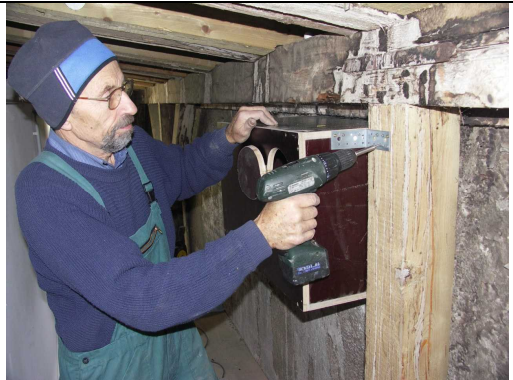
5 Befestigung des Kastens vor dem Fenster an der Wand.
